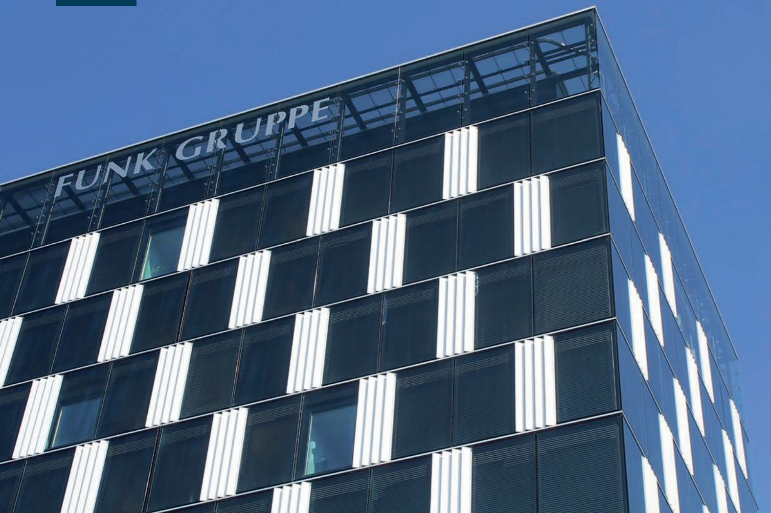
Der Funk Hub an der Hagenholzstrasse in Zürich.
